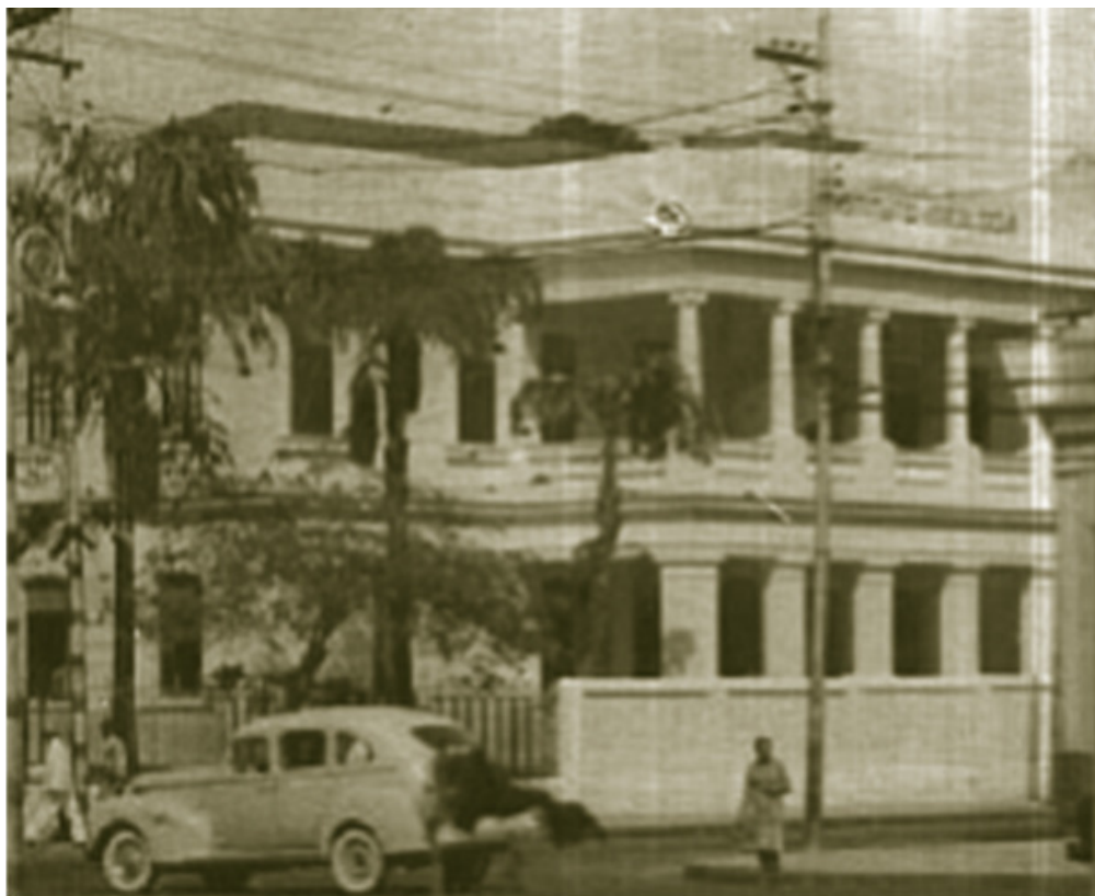
Imagem 2 - Fachada da Escola de Geologia do Recife em edifício situado à Rua Dom Bosco
