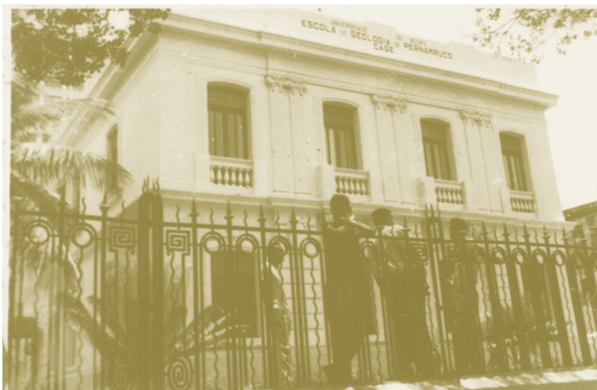
Imagem 1 - Fachada da Escola de Geologia do Recife, localizada na Rua do Hospício.
